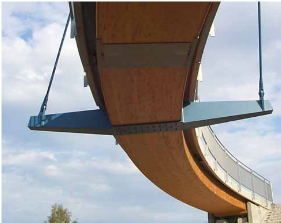
Abb. 6: Untersicht Blockträger mit Traverse und Stosselement Brücke Hochstetten
