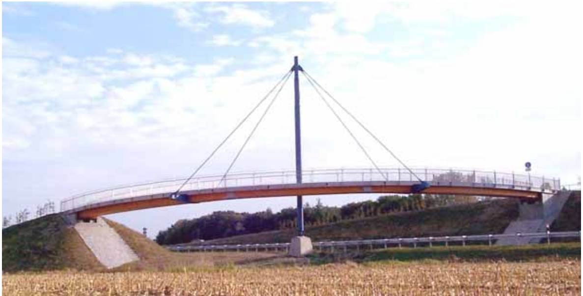
Abb. 3: Ansicht Brücke Hochstetten (D)
