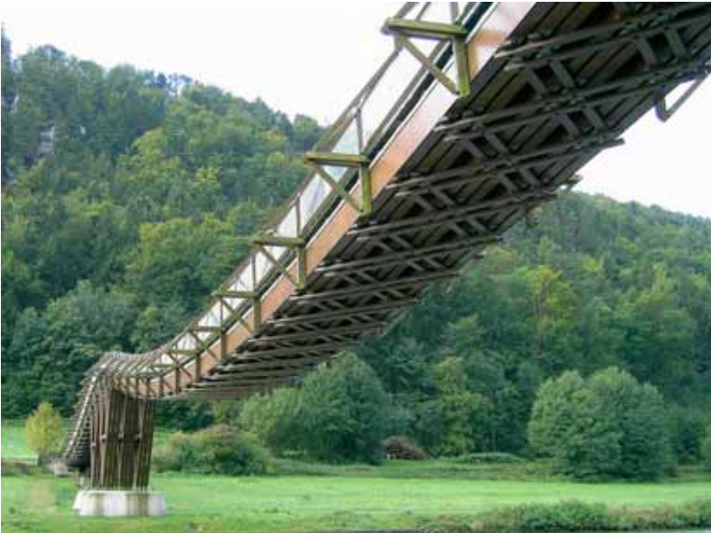
Abb. 8: Untersicht der Essinger Spannbänderbrücke, Baujahr 1978
