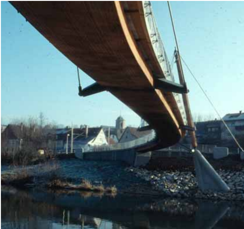
Abb. 1: Vorbild: Pylon- Blockträgerbrücke Wernau (D)
