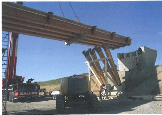
7 Einfädeln des Plattenbalkens © Schaffitzel Holzindustrie GmbH & Co. KG
