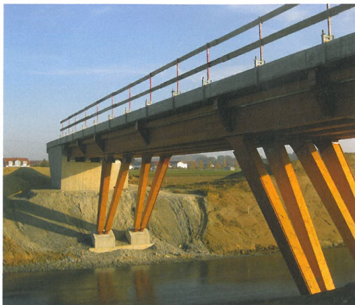
1 Montierte Sprengwerkbrücke © Schaffitzel Holzindustrie GmbH & Co. KG
