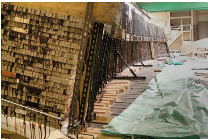
Versuche im Vorfeld ermittelten die nach der Verleimung zu erwartenden Rückstellkräfte. Die gefundenen Werte wurden benutzt, um die vorgegebene Toleranz von 2 mm einzuhalten.
