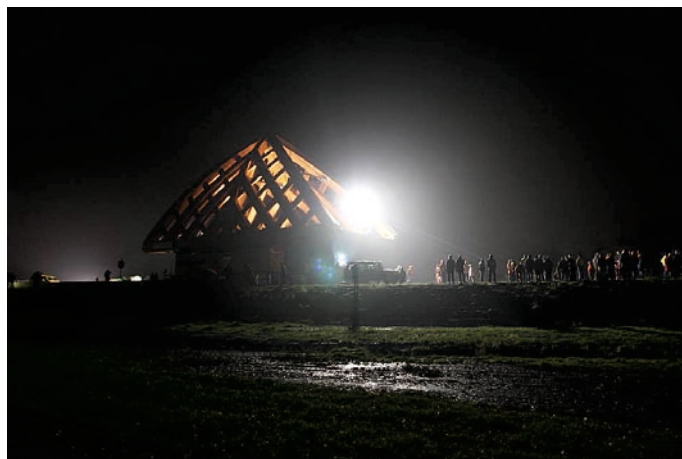
Den Anwohnern erschien die Errichtung der Brücke kurz vor Weihnachten 2008 als mitternächtliches Spektakel. .
