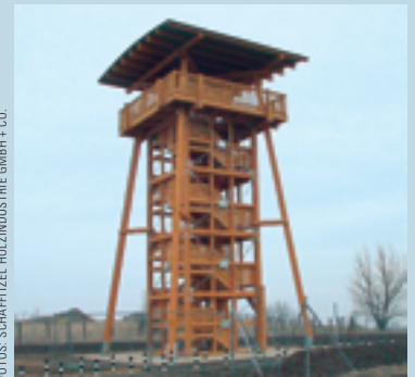
FOTOS: SCHAFFITZEL HOLZINDUSTRIE GMBH + CO.
