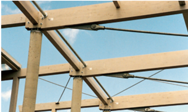
FOTOS: SCHAFFITZEL HOLZINDUSTRIE GMBH + CO.
