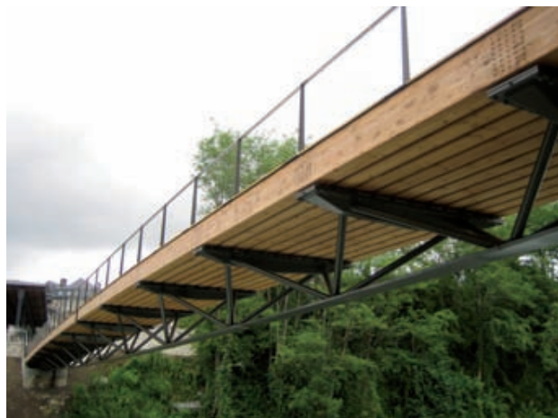
Abb. 4: Diese Brücke in Oloron in Frankreich – eine Holz-/Stahlfachwerkkonstruktion – überspannt mit einer Breite von drei Metern als Fußgänger- und Radfahrerbrücke eine Distanz von fünfzig Metern
