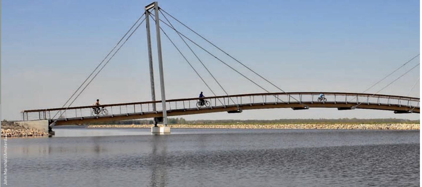
GANZ AUS HOLZ: die siebzig Meter lange und drei Meter breite Pylonbrücke „Zur blauen Stadt“ mit Fuß- und Radweg in Winschoten (Niederlande)
