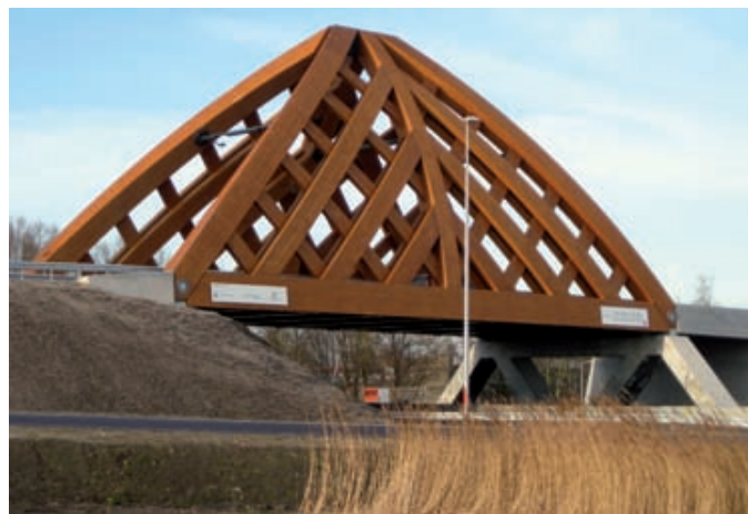
Abb. 3: Diese offene Fachwerkbrücke aus Accoya-BSH überquert mit ihrer Fahrbahnplatte aus Stahl auf einer Länge von 32 Metern die A 7 in der holländisch-friesischen Stadt Sneek
