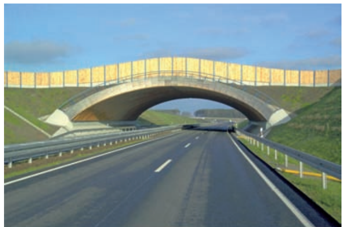
Abb. 2: Wild- und Grünbrücken werden immer häufiger gebaut; hier ist die erste Brücke dieser Art zu sehen, die vor fünf Jahren in Nordrhein-Westfalen als Pilotprojekt errichtet worden ist
