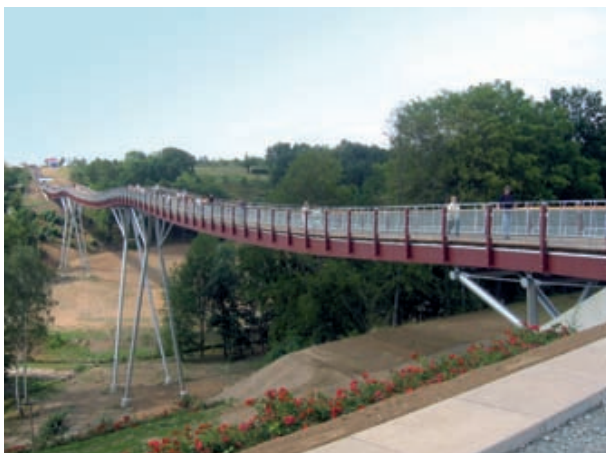
Abb. 1: Eine der längsten Holzbrücken Europas: die 240 Meter lange Erlebnisbrücke Drachenschwanz auf dem Gelände der Bundesgartenschau 2007 in Gera
