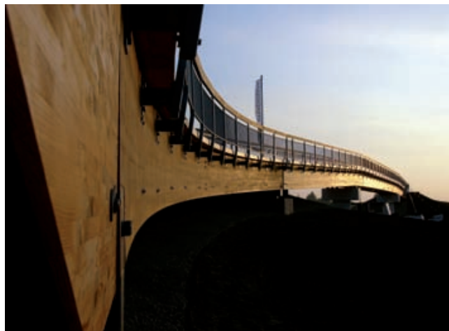
Abb. 6: Als Hohlkastenbrücke wurde diese markante, weit schwingende Fuß- und Radwegbrücke in IJsselstein in Holland konzipiert; sie ist 117 Meter lang und drei Meter breit
