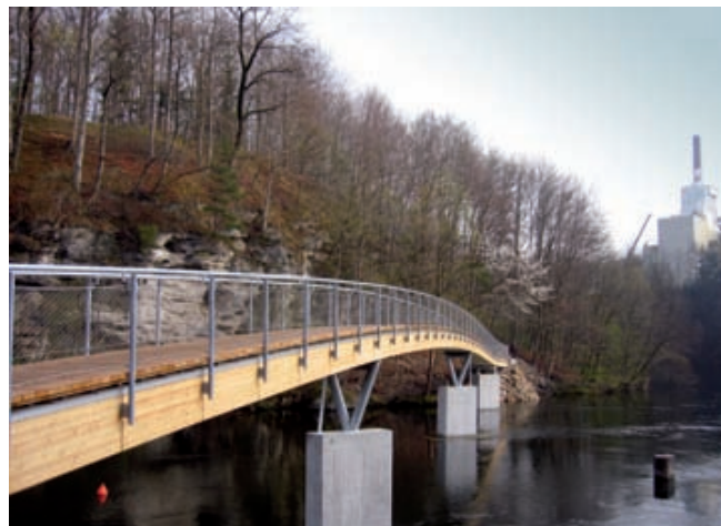
Abb. 5: Diese Blockträgerbrücke in Steyermühl in Österreich wurde seitlich mit Dreischichtplatten verkleidet; sie ist achtzig Meter lang und 1,60 Meter breit, das Gelände ist aus Stahl
