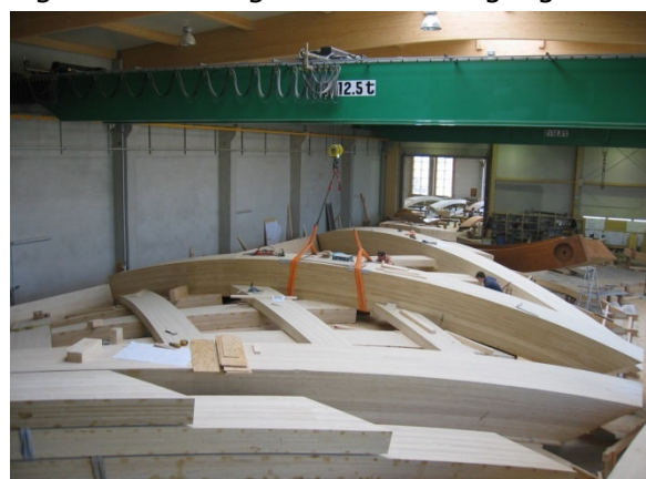
Auslegen in der Werkhalle
