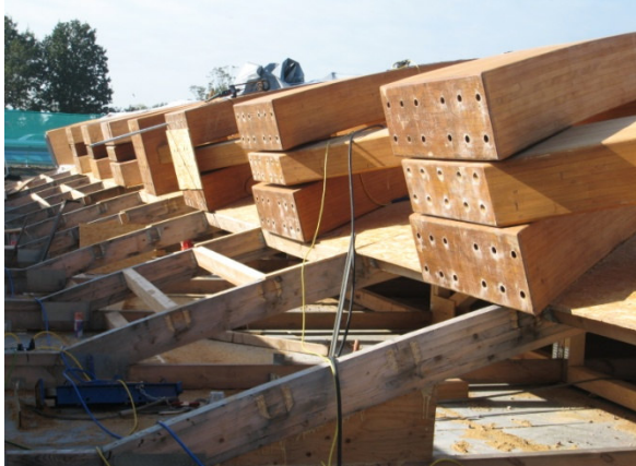
Diagonalenanschlüsse am Bauplatz
