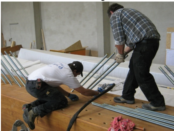
Präzision beim Bohren
