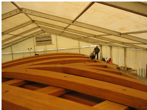
Verleimung im Klimazelt
