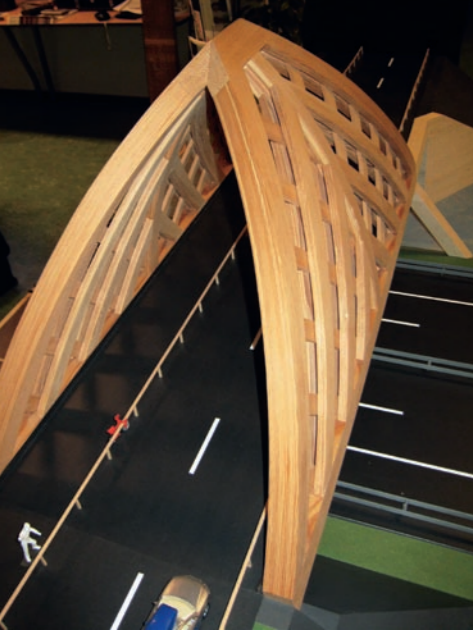
◀ Die Brücke soll an einen gotischen Bogen erinnern. Dafür erdachten die Planer eine komplexe Schalenkonstruktion
