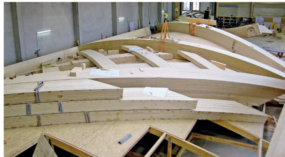
▼ Die Holzbauer verbauten zahlreiche unterschiedlich dimensionierte Holzstäbe und -planken
