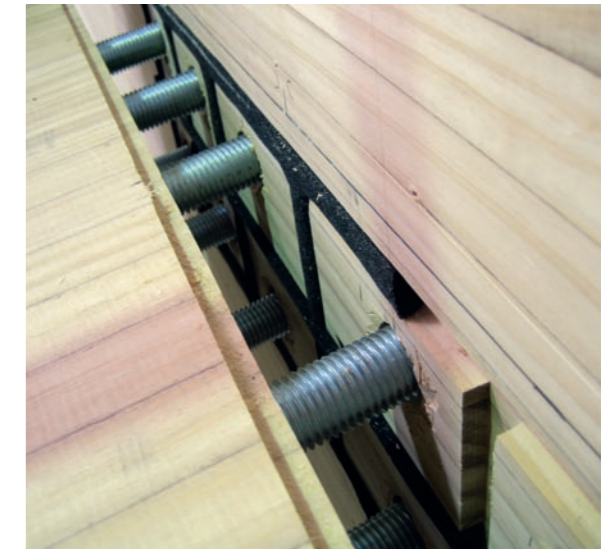
◀ In einem temperierten Zelt in der Nähe des späteren Standorts erfolgte die Verklebung der Gewindestangen
