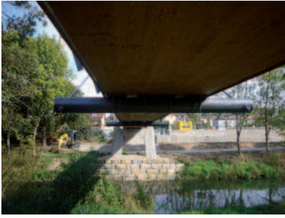
7 Massiver Blockträger © Ingenieurbüro Miebach
