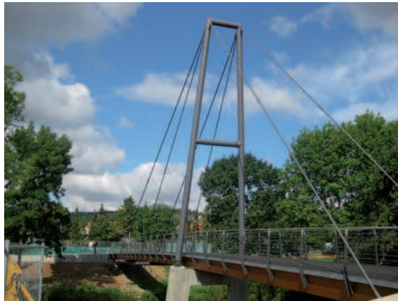
1 Fertiggestelltes Bauwerk © Schaffitzel Holzindustrie GmbH + Co. KG
