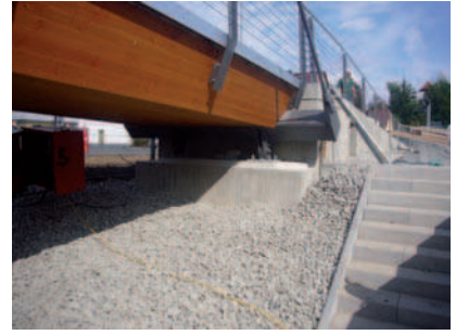
9 Auflager mit Rückverankerung © Ingenieurbüro Miebach
