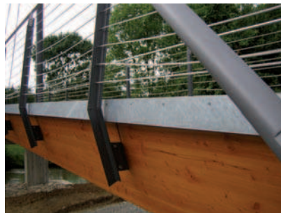
5 Fahrbahnanschluss... © Schaffitzel Holzindustrie GmbH + Co. KG
