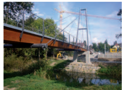
6 Pylon und Traversen aus Stahl © Ingenieurbüro Miebach
