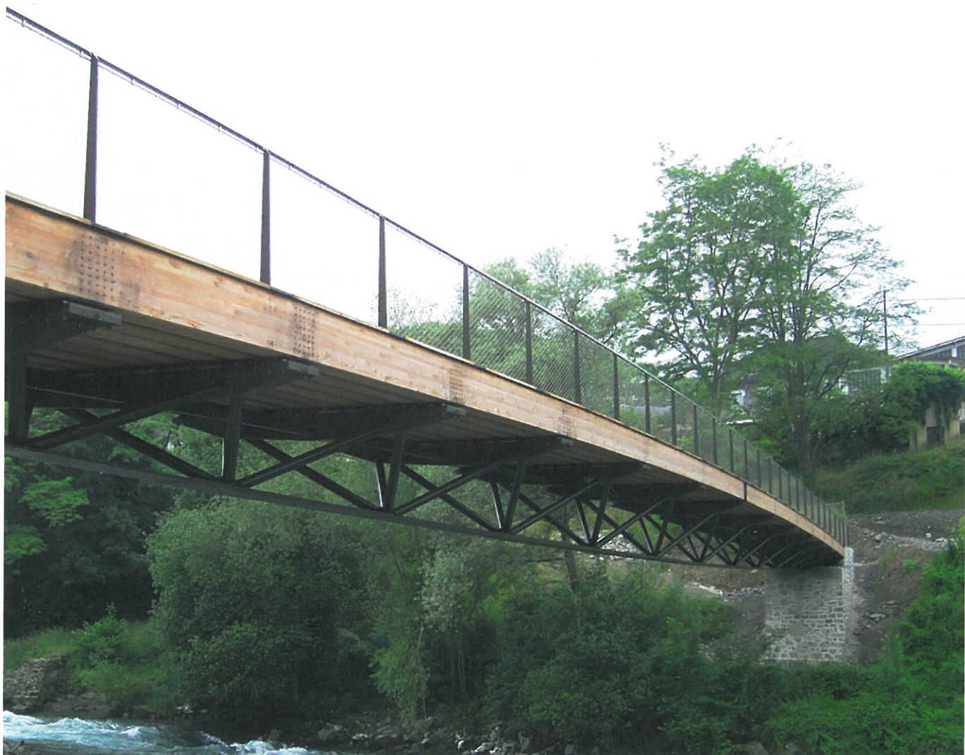
Passerelle à Oloron-Sainte-Marie.
